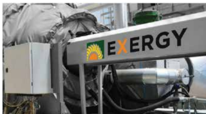
FIGURA 15 - Un esempio di turbina "outflow" progettata da Exergy installata in un campo geotermico
