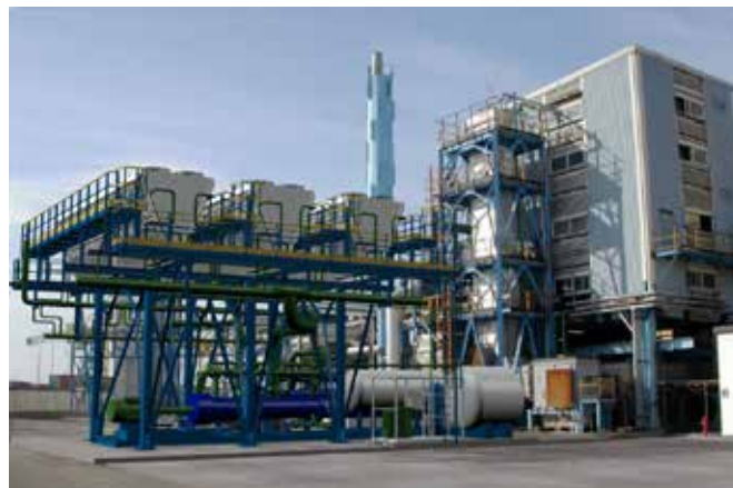
FIGURA 14 - Il prototipo da 500 kWel con ciclo ipercritico sperimentato al centro sperimentale ENEL di Livorno
